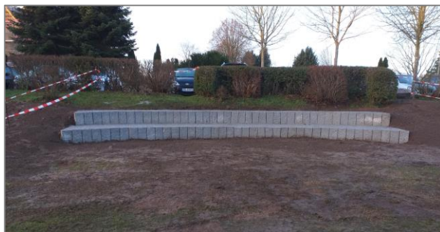
Abb. 3: Das grüne Klassenzimmer an der Schleischule in Rieseby als Amphitheater.
